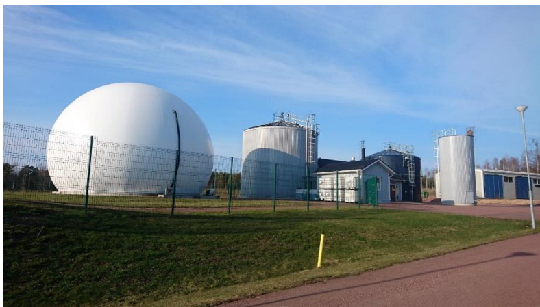
Figur 1 Gårdsanläggning på Ålands Centralandelslag, var biogas produceras av avfall från mejeriproduktion. En annan biogasanläggning finns vid reningsverket Lotsbroverket på Åland (Dahlsten, 2019).
